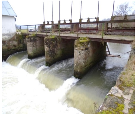
Abb. 23: Doppelter Sohlabsturz durch das Wehr
